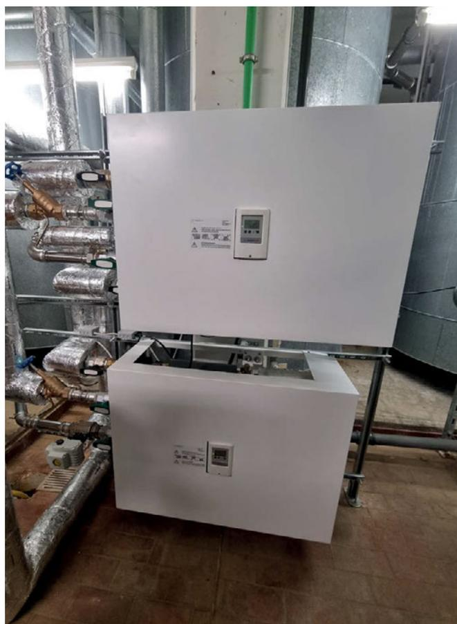
Das neue Konzept zur Warmwasserbereitung in Stralsund fußt auf Frischwasserstationen
